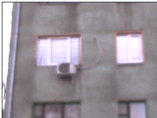
Рисунок НА.2 – Фото фрагмента обстежуваної конструкції
