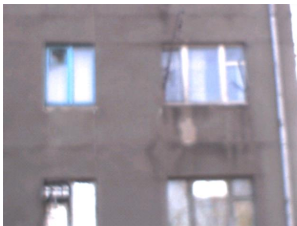
Рисунок НА.2 – Фото фрагмента обстежуваної конструкції
