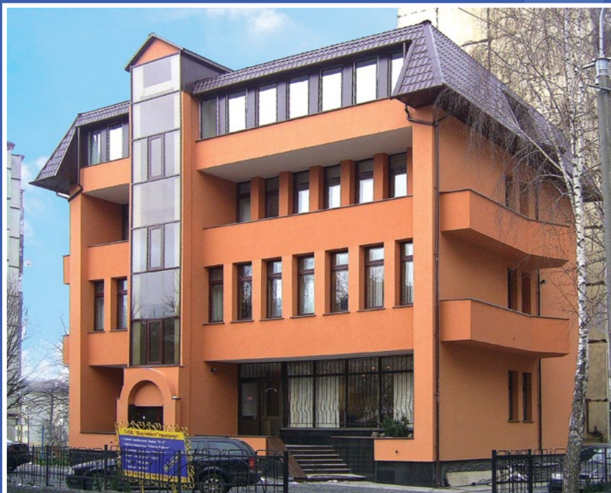
Офіс будівельної компанії «Сіменс-Габро» у м. Рівному.
